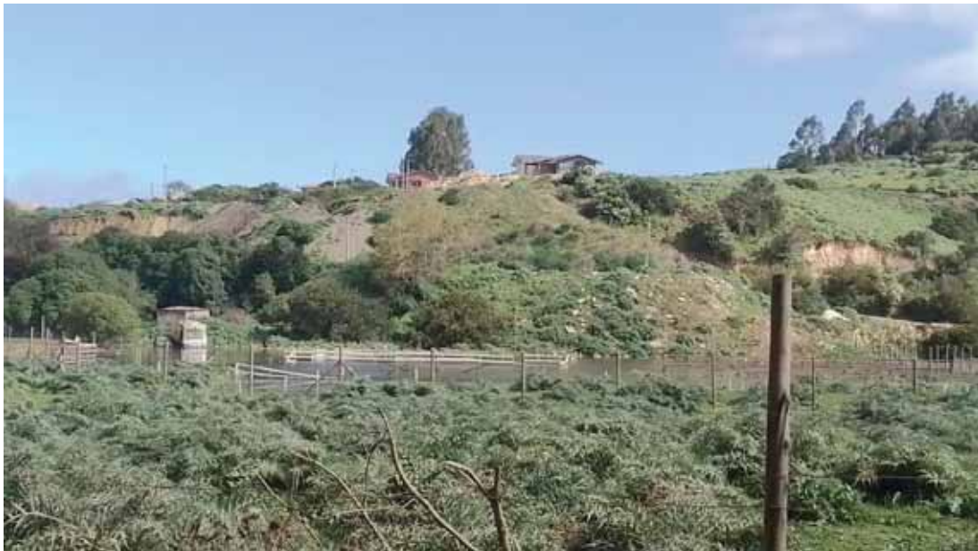
Foto 2: Venta de parcelas en zona de inundación por anegamiento y amenaza de remoción.
