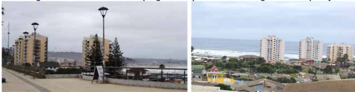
Figura II-66 Vivienda en altura que genera impactos visuales negativos en el paisaje
